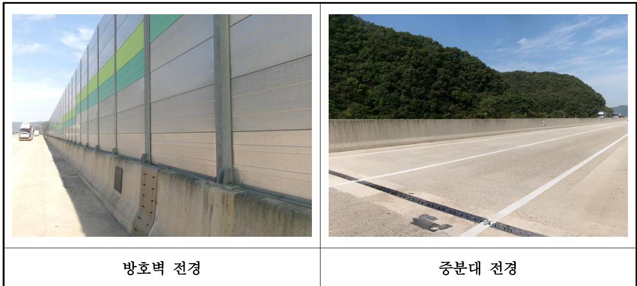
【사진 18.3.23】 방호벽 및 중앙분리대 전경
