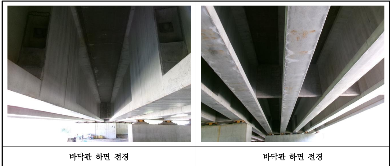
【사진 18.3.2】 바닥판하면 전경
