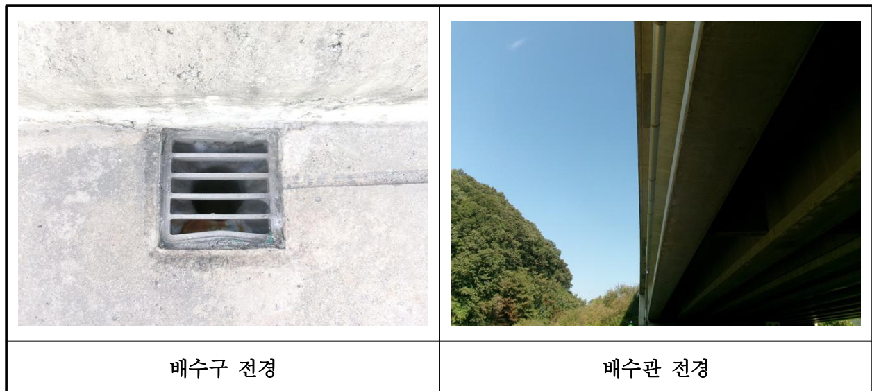
【사진 18.3.46】 배수시설 전경
