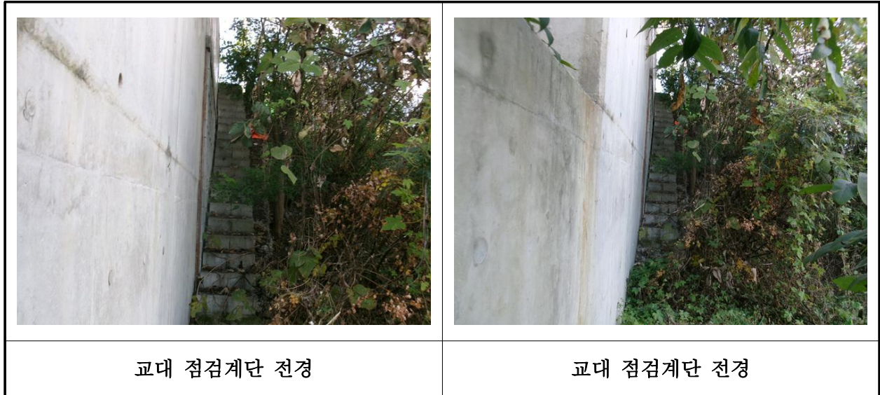
【사진 18.3.25】 교량 점검시설 전경
