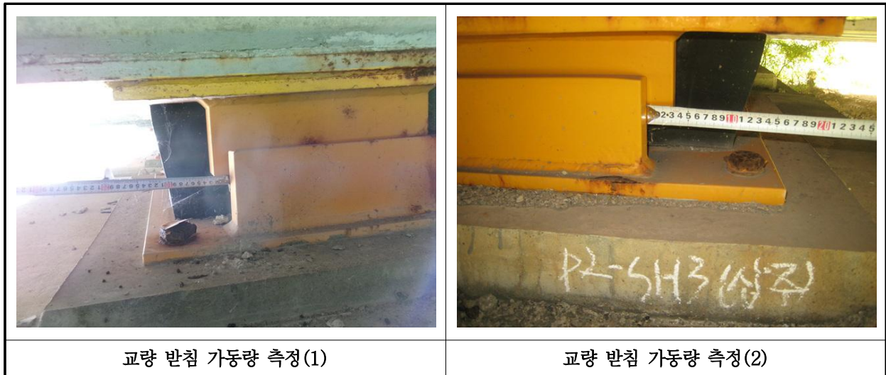
【사진 18.3.15】 교량받침 이동량 측정
