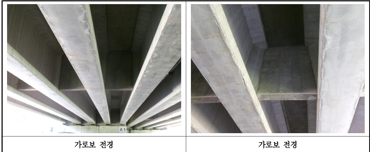
【사진 18.3.31】 가로보 전경
