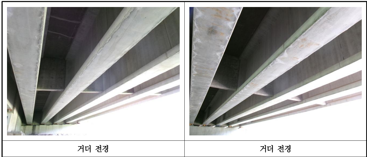
【사진 18.3.4】 거더 전경
