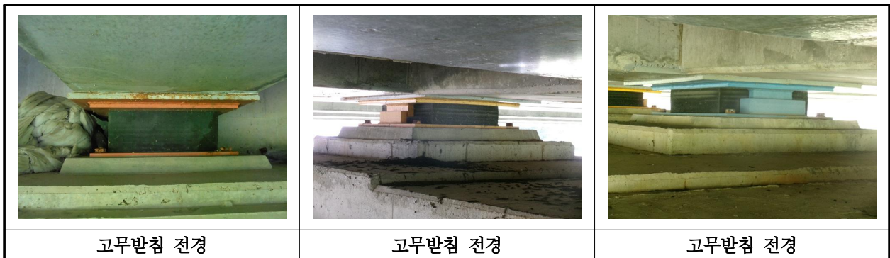
【사진 18.3.35】 교량받침 전경
