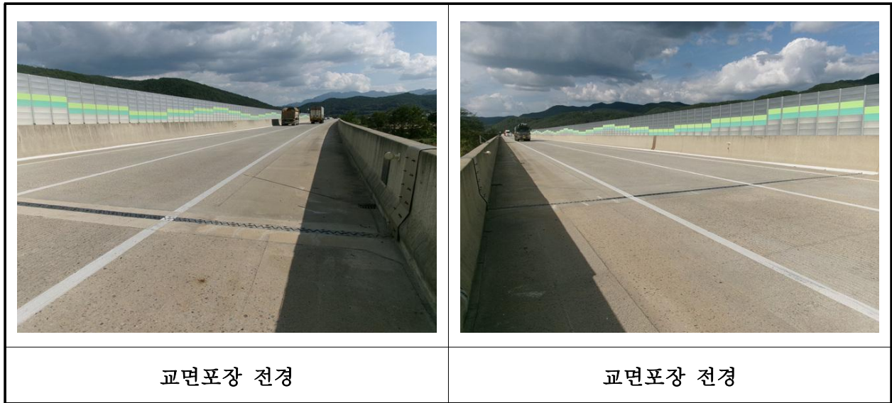
【사진 18.3.44】 교면포장 전경
