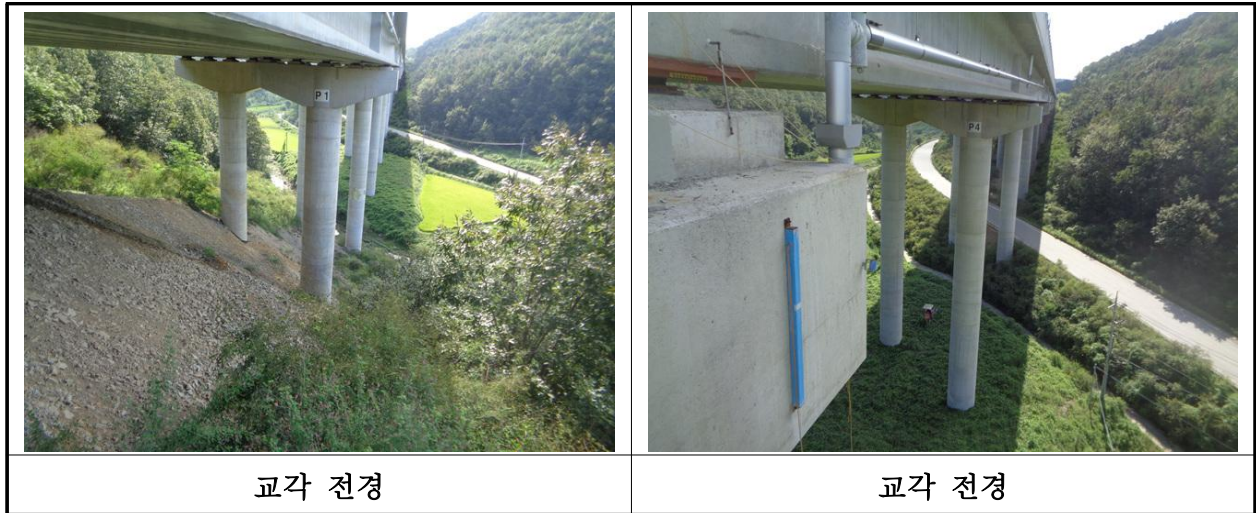
【사진 18.3.35】 교각 전경
