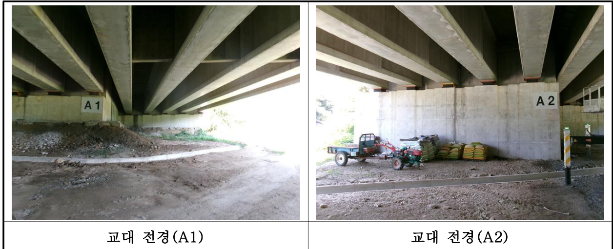
【사진 18.3.8】 교대 전경
