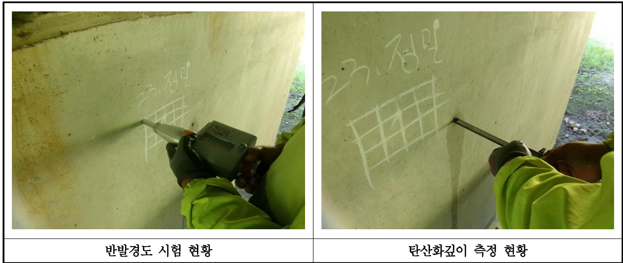
【사진 18.4.1】 콘크리트 내구성조사 현황
