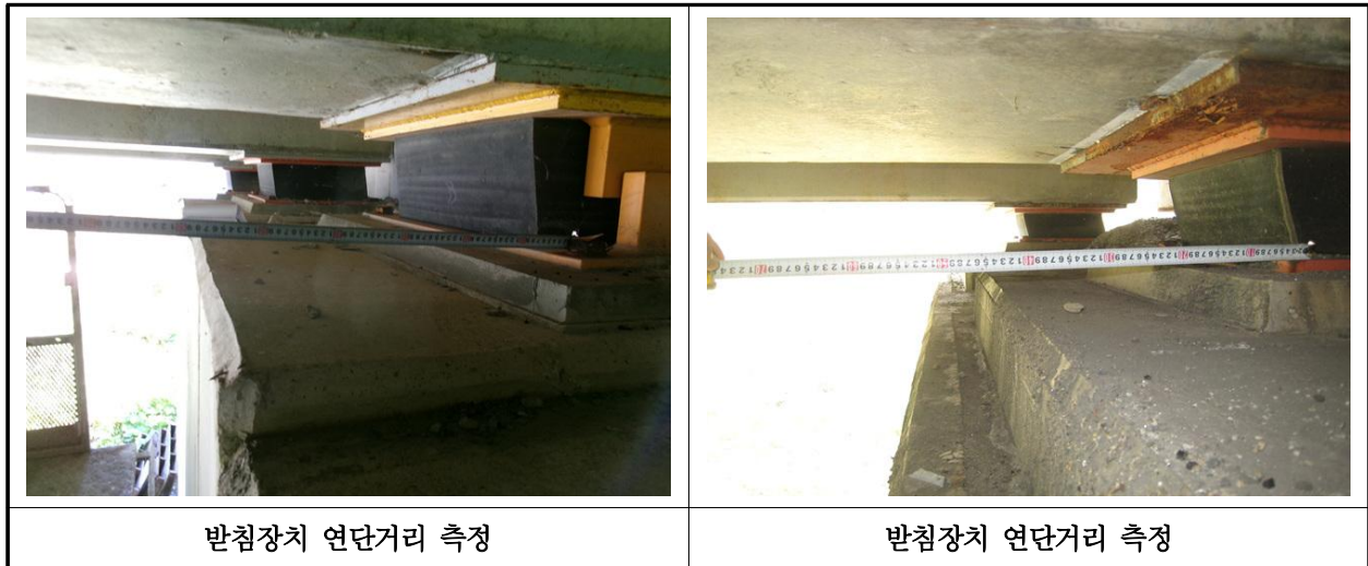
【사진 18.3.14】 교량반침장치 연단거리측정
