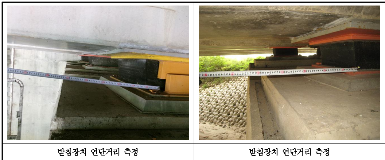
【사진 18.3.39】 교량받침장치 연단거리측정
