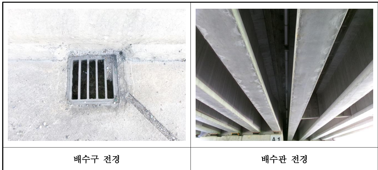
【사진 18.3.21】 배수시설 전경
