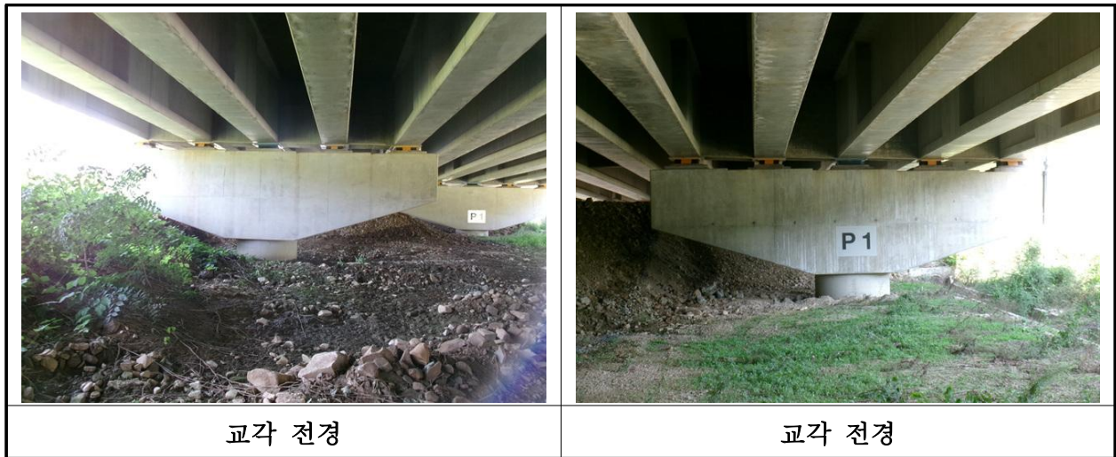
【사진 18.3.10】 교각 전경
