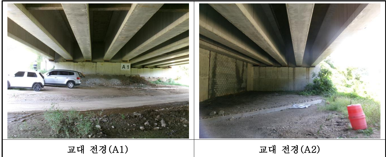
【사진 18.3.33】 교대 전경
