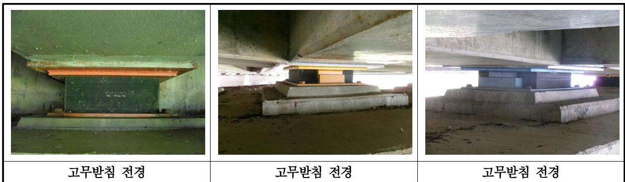
【사진 18.3.12】 교량반침 전경
