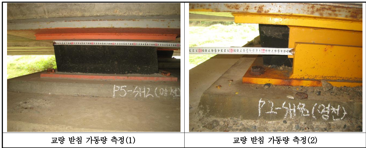
【사진 18.3.40】 교량받침 이동량 측정
