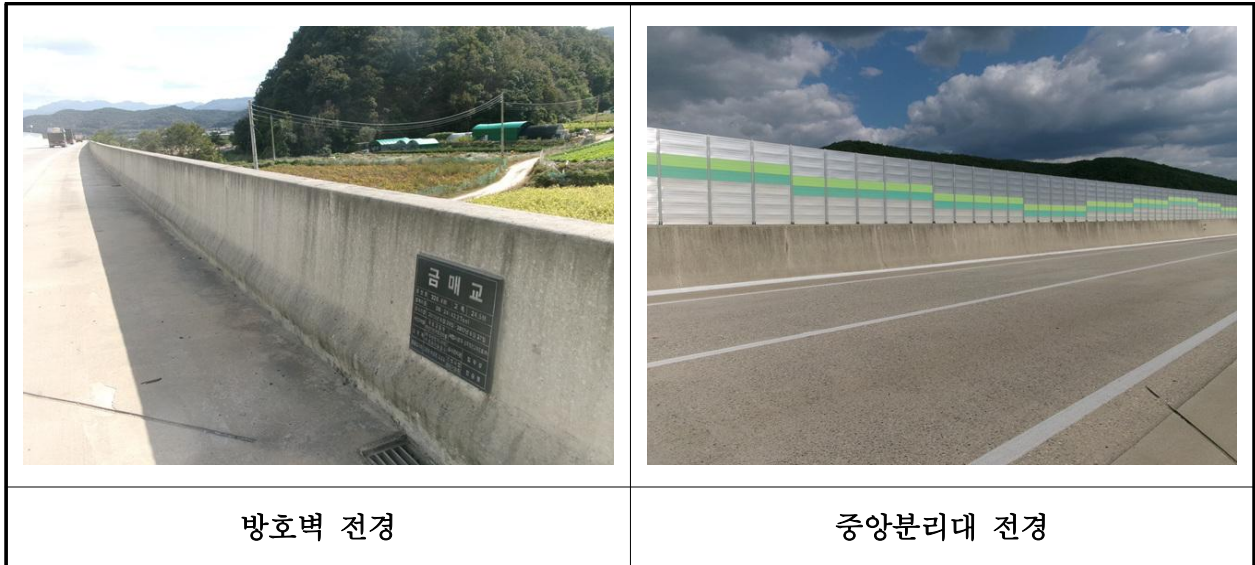
【사진 18.3.48】 방호벽 및 중앙분리대 전경
