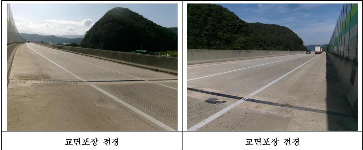
【사진 18.3.19】 교면포장 전경
